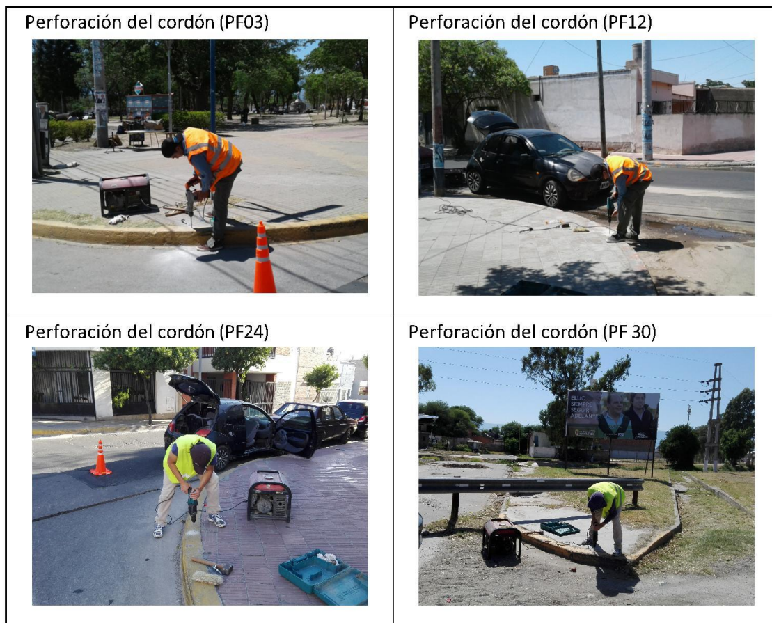
Figura 30. Fotografías capturadas durante el proceso de perforación del cordón.
